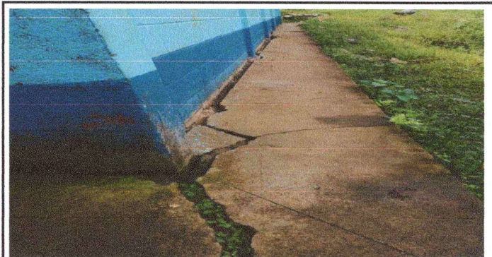
FOTO 4: REHABILITACIÓN DE PISO DE CONCRETO DEL MÓDULO 1
