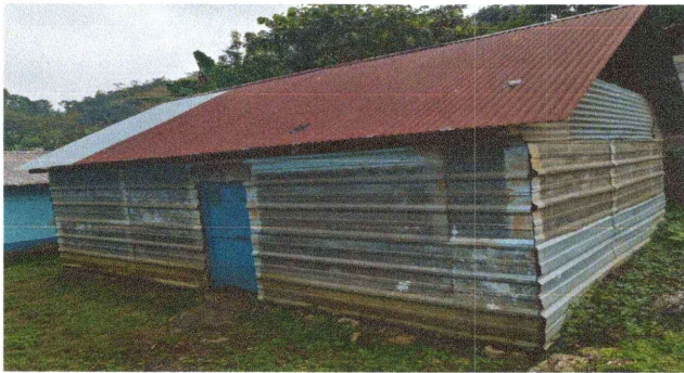
FOTO 1: REHABILITACIÓN DEL MÓDULO 3
